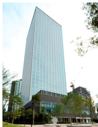
▲新宿フロントタワービル外観
